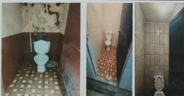
Foto 3: MODULO DE SERVICIOS SANITARIOS con aplicacion de azulejo en muros y sustitucion de sanitarios en mal estado.
