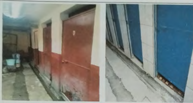
Foto7: MODULO DE LAVANDERIA Y SERVICIOS SANITARIOS Vista de puertas de metal remozadas y pintadas.
