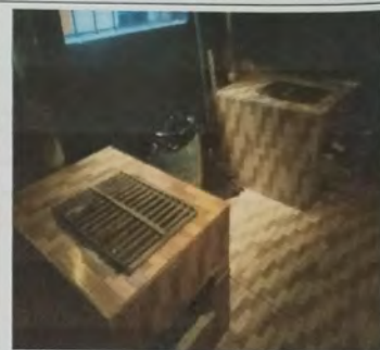
Foto 14: MODULO DE COCINA Remozamiento de poyetones con instalacion de piso ceramico.
