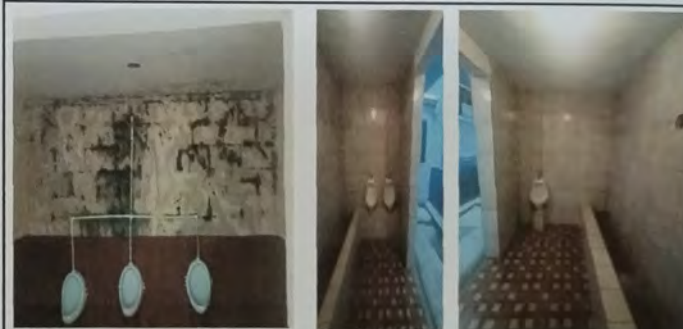
Foto 4: MODULO DE SERVICIOS SANITARIOS con aplicacion de azulejo en muros y sustitucion de sanitarios en mal estado.
