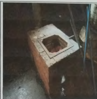
Foto 14: MODULO DE COCINA Remozamiento de poyetones con instalacion de piso ceramico.
