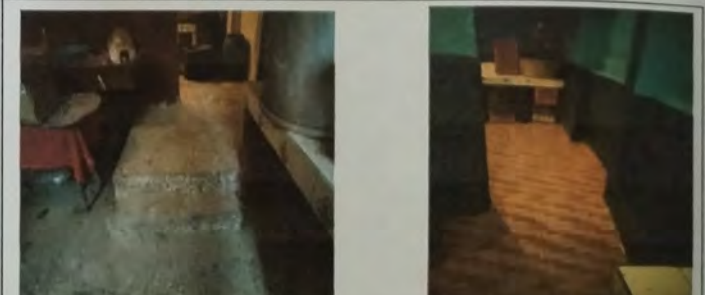
Foto 12: MODULO DE COCINA Vista de acceso caminamiento a cuarto de almacenamiento de leña, donde se eliminan las gradas de concreto y dejando libre el acceso, instalacion de piso ceramico.
