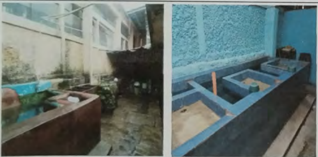
Foto 9: VISTA DE REMOZAMIENTO DE PILA
