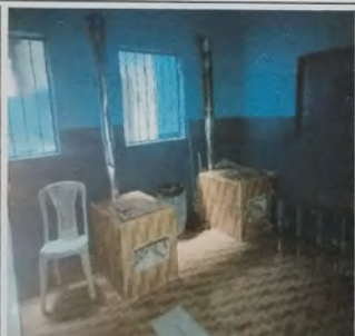
Foto 15: MODULO DE COCINA Remozamiento de poyetones con instalacion de piso ceramico. Se cambiaron de altura los vanos de las ventanas.
