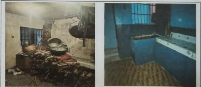
Foto 10: MODULO DE COCINA, se instalo ceramico en mueble de concreto pegado a la puerta de ingreso debajo de la ventana. Al igual se instalo piso ceramico.
