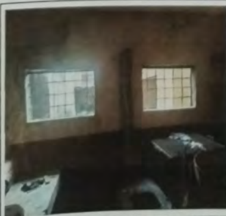
Foto 17: MODULO DE COCINA Remozamiento de poyetones con instalacion de piso ceramico. Se cambiaron de altura los vanos de las ventanas.
