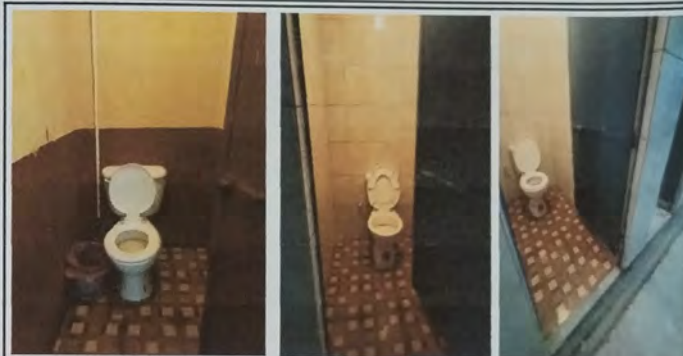
Foto 2: MODULO DE SERVICIOS SANITARIOS con aplicacion de azulejo en muros y sustitucion de sanitarios en mal estado.
