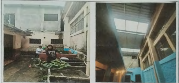
Foto 8: MODULO DE LAVANDERIA Y SERVICIOS SANITARIOS area se le instala cubierta de lamina troquelada cal 26 con soporte a base de costaneras de metal
